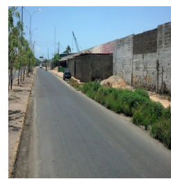
Daño ecológico y de infraestructura causado por Fextún a la comunidad del Dique.
