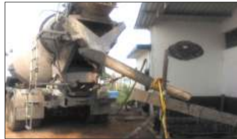
Momentos cuando es vaciado el Concreto para el tanque de agua de la UNEG
