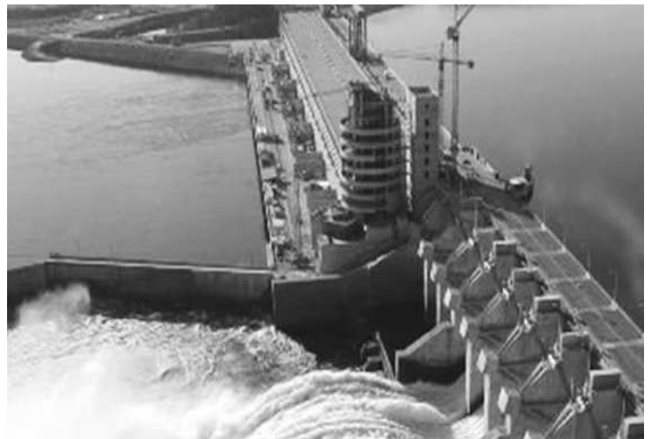
Central Hidroeléctrica Caruachi. Tercer complejo en su tipo instalado en el cauce del río Caroni. Con 12 unidades generadoras, potencia nominal 2.196 Megavatios; Energía firme 11.350 Gigavatios, representa el 12% de la demanda eléctrica del país.
